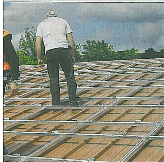
mann und Vertriebsleiter Richard Kühnel schauten r Montage der Gestelle für die Module suchten sie i Dach der Halle. Bild: ha
