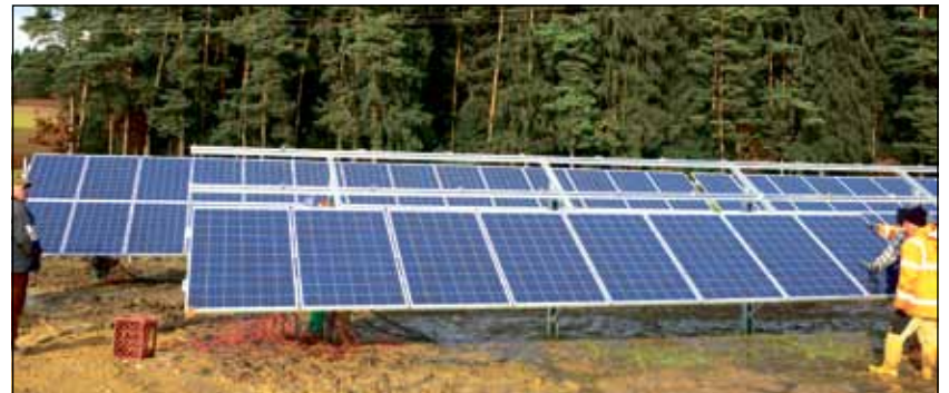
Die ersten Solarmodule wurden bereits installiert.
