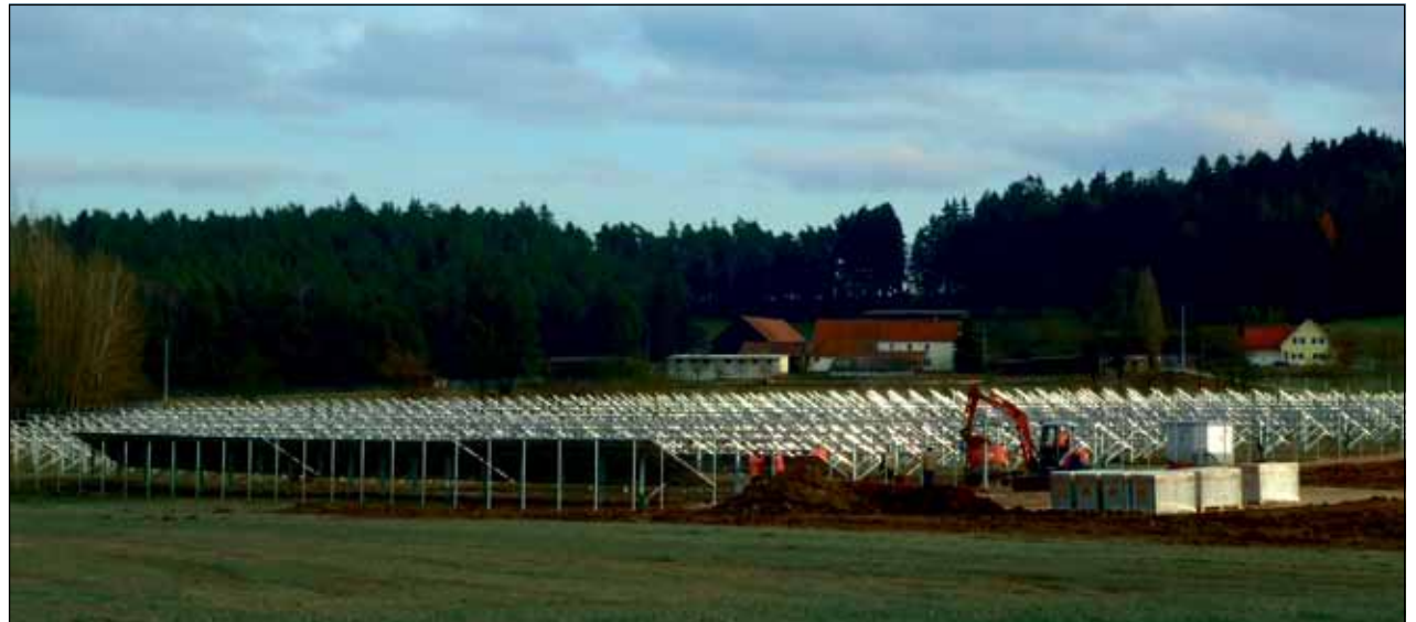
Unser Bild zeigt den Beginn der Rammarbeiten, welche die Firma Schletter mit Spezialgeräten ausführt. Der Solarpark in Barbaraberg bei Speinshart wird im Dezember ans Netz gehen.
